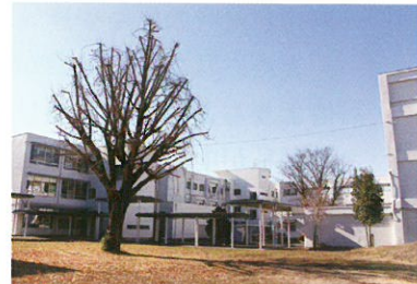
東方より校舎を望む
