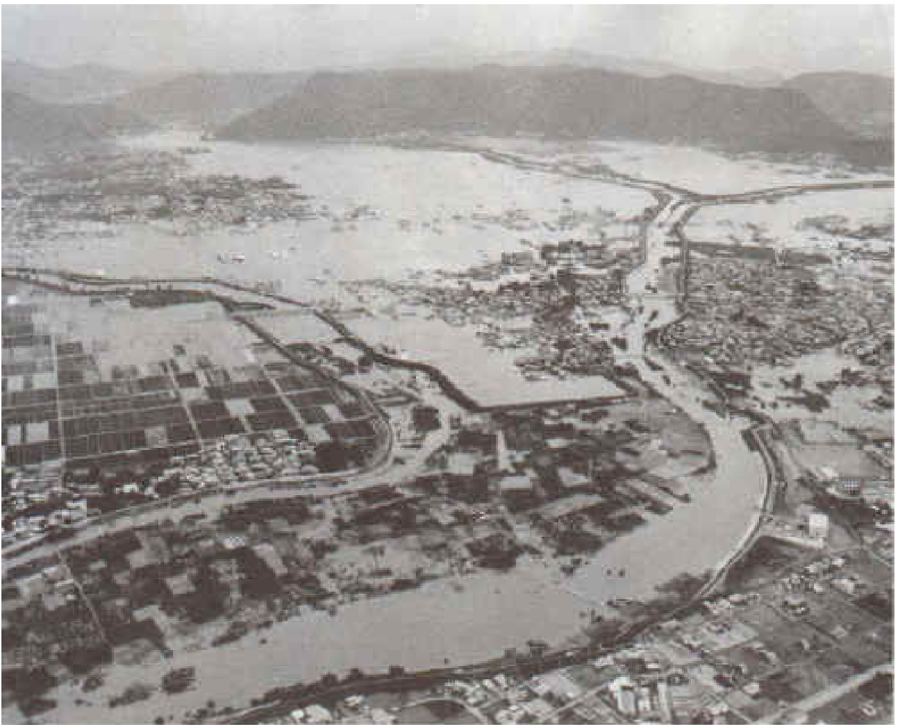
↑ 岐阜市の伊自良川の堤防が切れて、水が流れ出している様子
