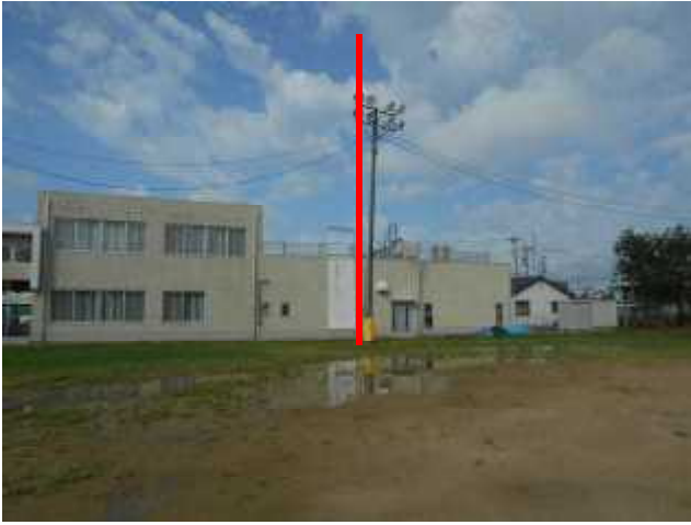
小中グラウンド ナイター設備 電柱 傾倒 根元陥没
